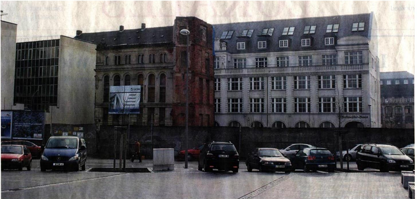
Triste Gegenwart: Am Rand des Karlsplatzes steht eine Bretterwand, die die Brachfläche mit dem letzten Rest des Geutebrück-Baus von 1846 umschließt. Foto: Jens Rometsch
