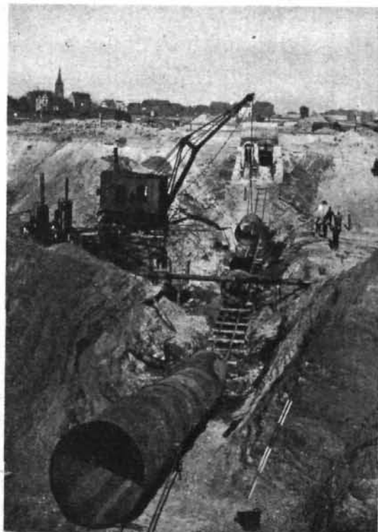
Abb. 9. Verlegen der Rohre des Mittelwasserdückers vom Südufer aus gesehen.
