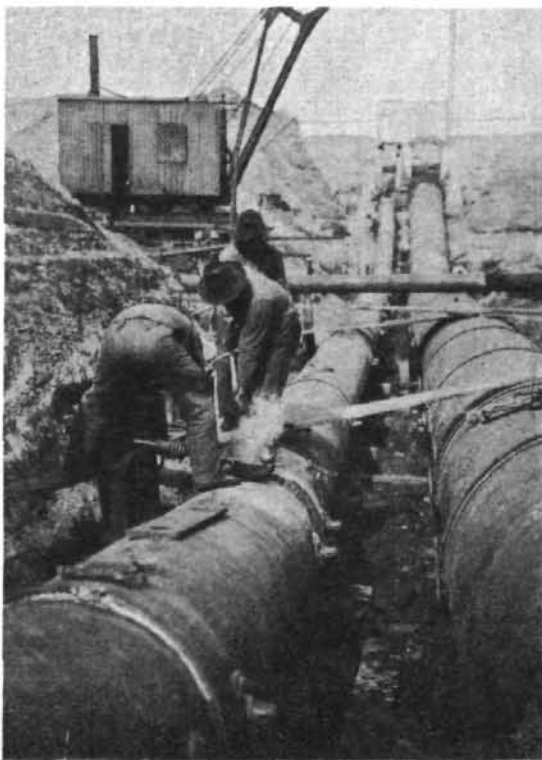
Abb. 8. Vergrößern der Muffen beim N.W.-Rohr.
