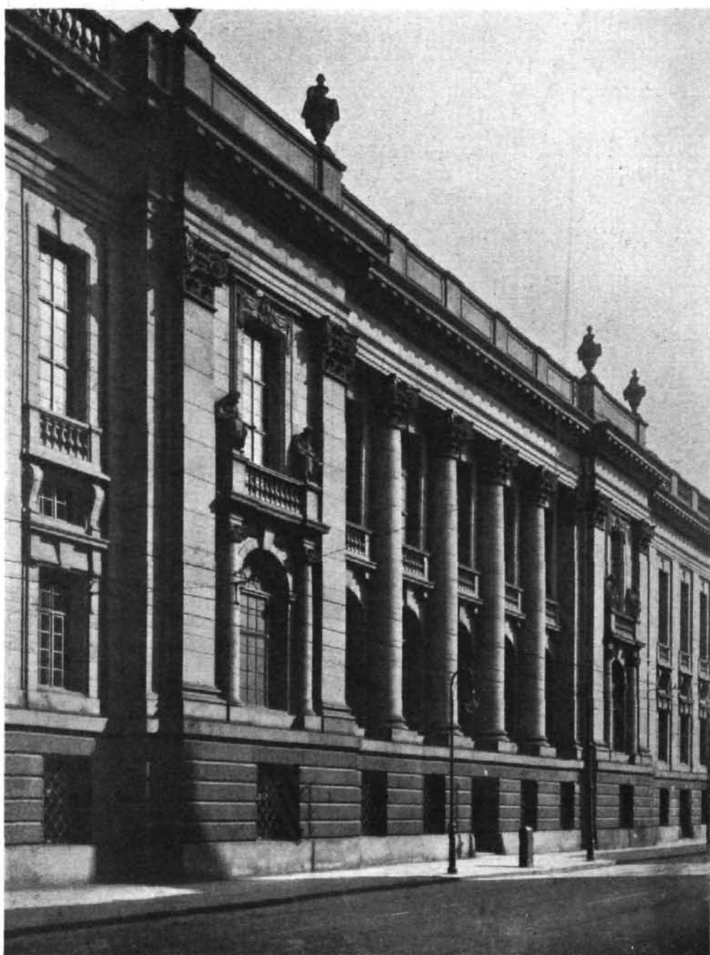
Abb. 9. Mittelbau der Seite in der Charlottenstraße.
